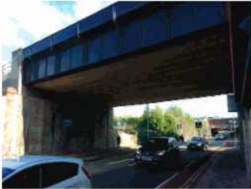
ਅੰਡਰ-ਬ੍ਰਿਜ (Under bridge)
